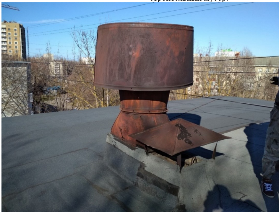
Рис. 3. Выход вентиляционных шахт и дымоходов на кровле
